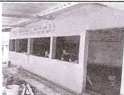
Foto 6: Repellado exterior de las paredes de la cocina del centro educativo
