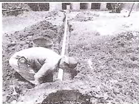
Foto 5: Instalación de tuberías para desviar las aguas de los cuatro sanitarios.
