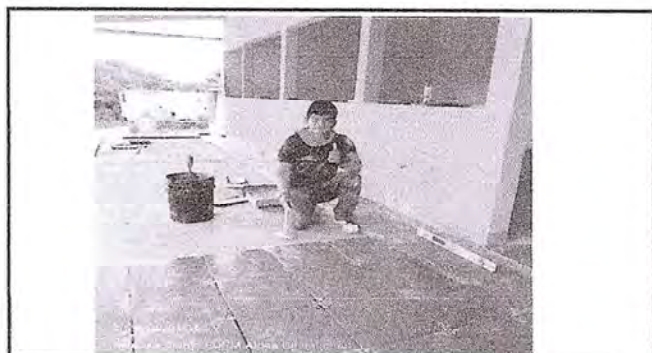
Foto 4: Se observa el avance en la instalacion de piso ceramico en el corredor de la cocina del centro educativo.
