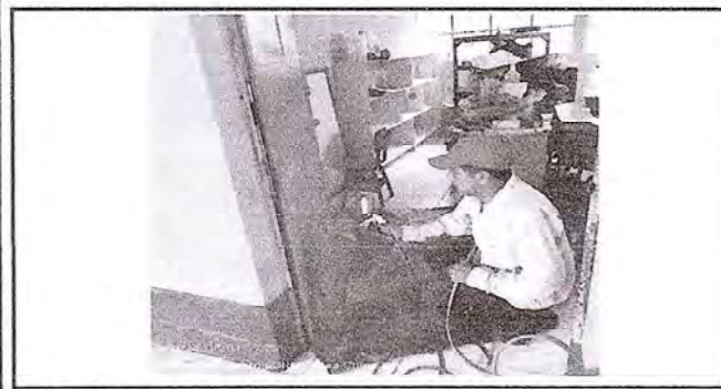
Foto 5: Se observa la aplicación de pintura a las puerta de modulos de clase.
