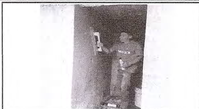
Foto1: Trabajos en repello en sanitarios.
