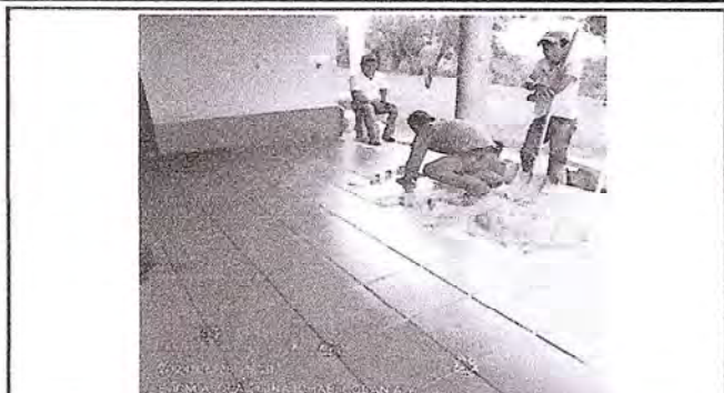
Foto 2: Proceso de instalacion de piso ceramico en el corredor del aula de preprimaria.
