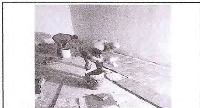
Foto 3: Proceso de instalacion de piso ceramico en la cocina del centro educativo.
