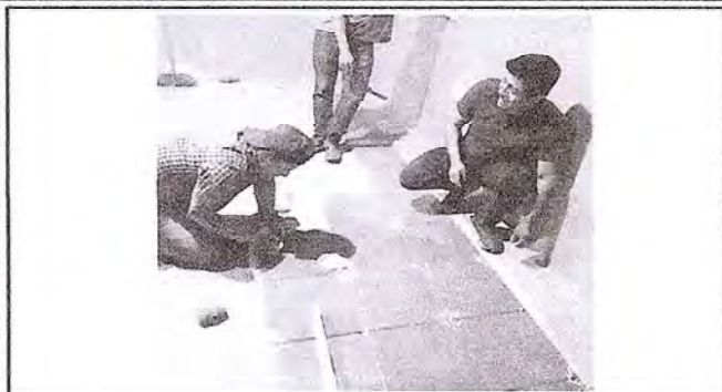
Foto1: Inicio de colocacion de piso ceramico en el aula de preprimaria.
