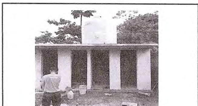
Foto 4: Repellado de las paredes de los cuatro sanitarios.
