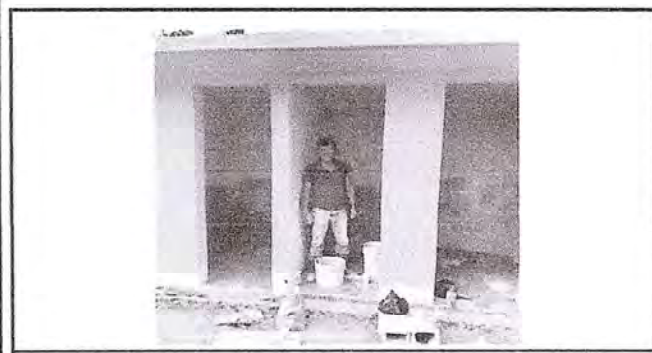
Foto 5: Se observa el avance de instalacion de piso en los sanitarios.
