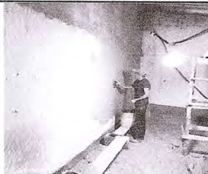
Foto 4: Aplicación de repello en la cocina del centro educativo
