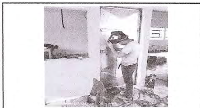
Foto 3: Instalacion de puerta de la cocina del establecimiento.
