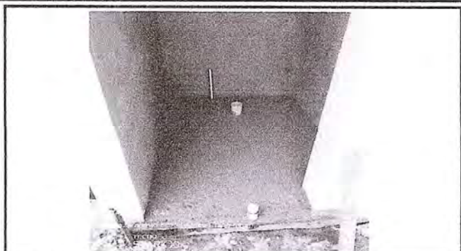
Foto 2: Fundicion de concreto en sanitarios.
